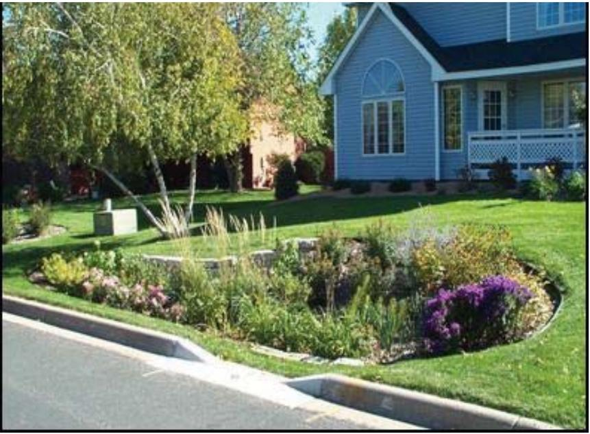
Hay dos tipos básicos de jardines de lluvia – bajo drenado y auto contenida. Ambos tipos de jardines de lluvia se utilizan para mejorar la calidad de las aguas pluviales, reducir los volúmenes de escorrentía y en general facilitan la infiltración del agua limpia.
