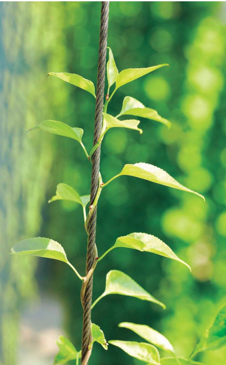
Este sistema está basado en las fachadas vegetales tradicionales, pero con la diferencia que se utilizan superficies verticales, como enrejado de acero inoxidable o galvanizado, alambres, mallas como apoyo estructural para el crecimiento de las plantas.
