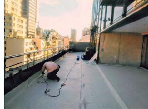
*Los puntos débiles del pvc son las babetas. Impermeabilizamos con monotop. Clavamos al muro chapa colaminada con Sika Flex 1A de junta y fusionamos la babetta de membrana pvc. Lo protegemos de los rayos UV con cupertina galvanizado.*
