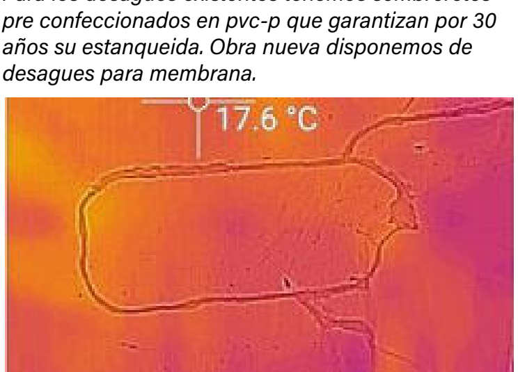
Luego de la prueba de agua comprobamos toda la superficie con cámara térmica a fin de constatar la ausencia de filtraciones.
