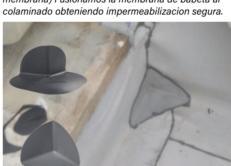
En esquinas de desplorijas donde no se puede hacer soldadura de 40 mm de ancho colocamos esquineros pre hechos confeccionados en pvc-p. La membrana de pvc-p fusiona solo con si mismo.
