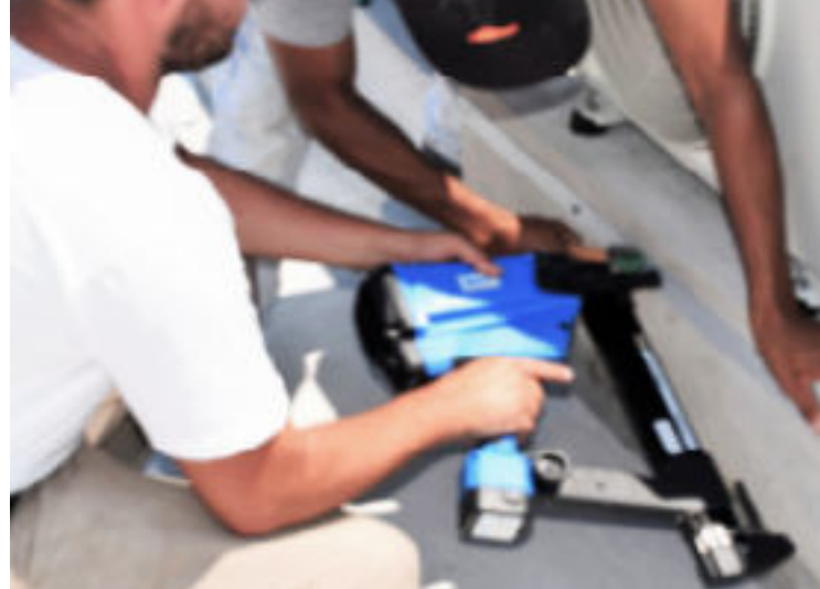
Fijamos mecánicamente colaminado (planchuela galvanizada cubierta del mismo PVC- p que la membrana) Fusionamos la membrana de babeta al colaminado obteniendo impermeabilización segura.
