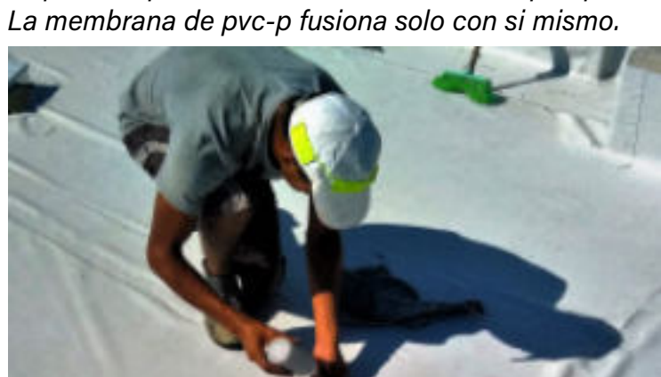
Como fin de la impermeabilización y para evitar que por capilaridad el agua ingrese por los hilos de poliester del alma de la membrana colocamos pvc líquido
