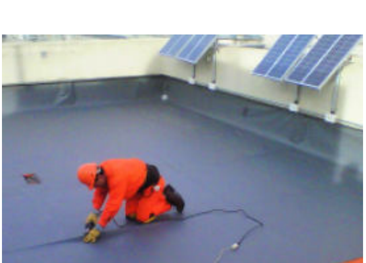
Impermeabilizamos fusionando las membranas de pvc-p con aire caliente a 700° y presión. Las babetas se fusionan a la membrana del piso y al colaminado.
