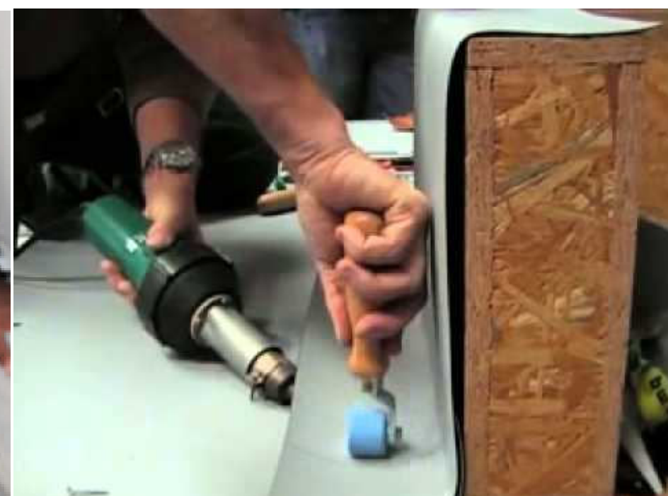
Impermeabilizamos fusionando las membranas de tpo o PVC con aire caliente a 650/700° y presión Las babetas se fusionan a la membrana del piso para evitar que se inflen
