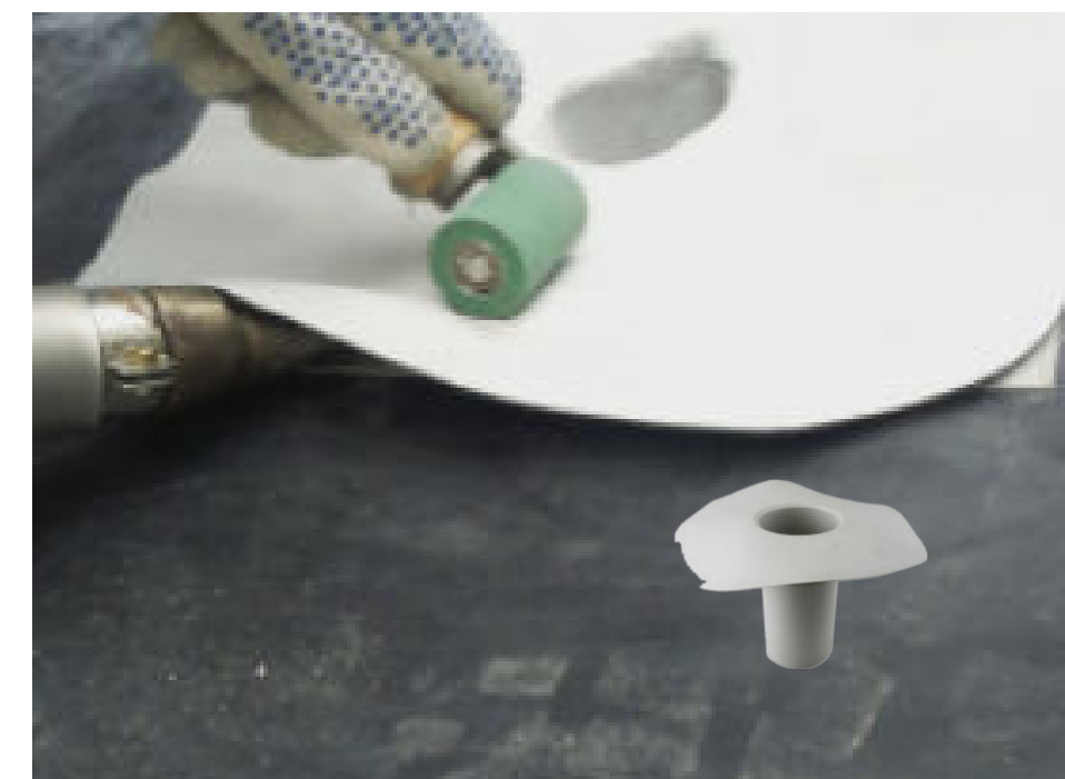
Para los desagües existentes tenemos sombreretes pre confeccionados en TPO o PVC que garantizan por 30 años su estanqueidad. Obra nueva disponemos de desagües para liner
