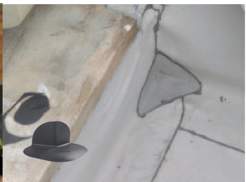
En esquinas desprolijas donde no se puede hacer soldadura de 40 mm de ancho colocamos esquineros pre hechos confeccionados en tpo o PVC sin refuerzo.
