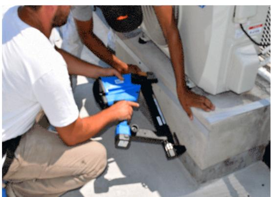
PVC fijamos mecánicamente la varilla de colaminado. TPO la varilla de Al se coloca luego de la babeta
