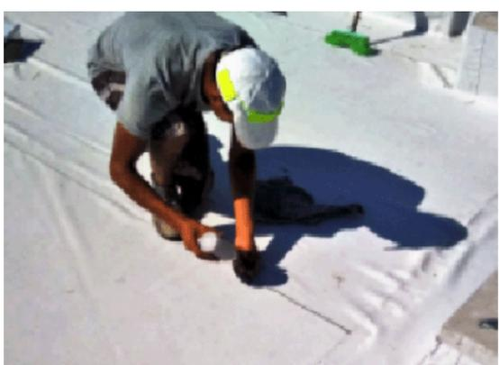
Como fin de la impermeabilización, sellamos los bordes de corte con silicona pura o pvc líquido, según corresponda.
